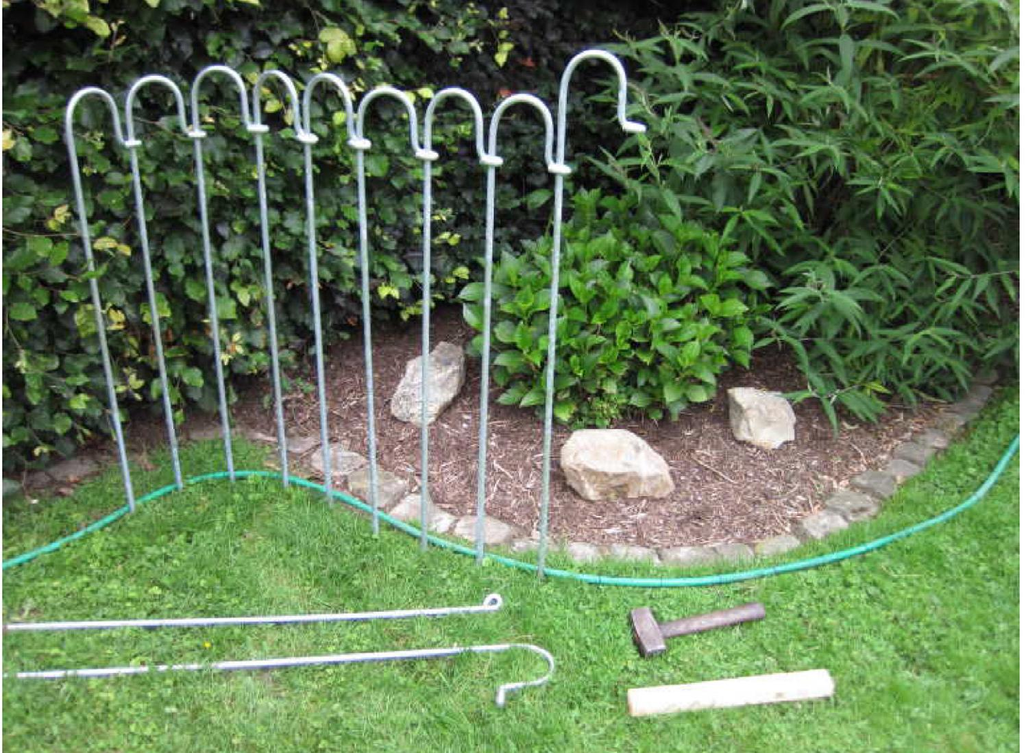
Enfoncez au marteau la première crosse au point de départ de votre tracé de clôture (Tenez un morceau en bois entre le marteau et les crosses galvanisées, afin d'éviter d'endommager la galvanisation). Insérez la crosse suivante par l'anneau de la précédente et l'enfoncer dans le sol. Contrôlez régulièrement que toutes les crosses sont installées verticalement parallèle.
